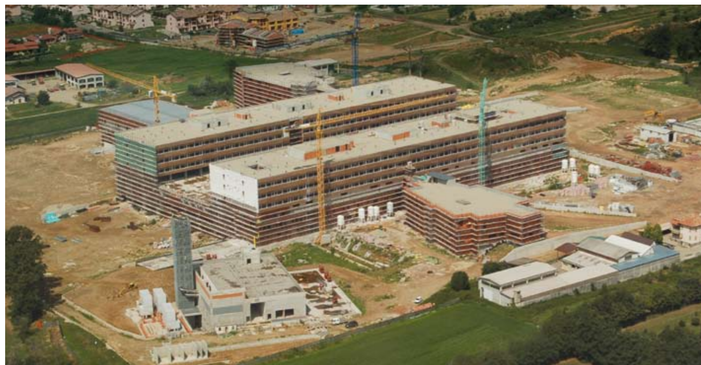
Vista aerea dell'ospedale (foto: Impresa De Lieto)
