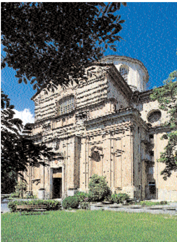
Facciata del Santuario di Graglia
